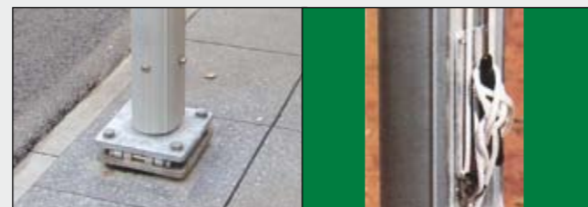
Sicherheitsmast Detail: Kippgelenk
