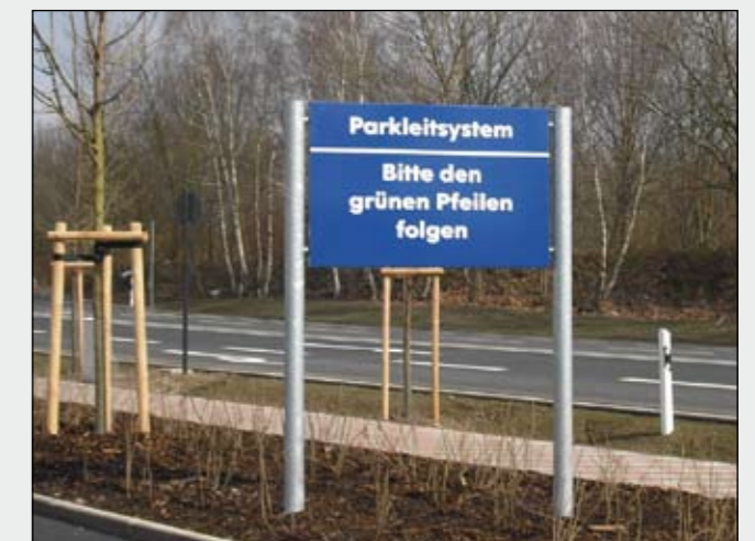
Hinweisschild 1.000 x 500 mm mit verzinkter Stahl-Unterkonstruktion
